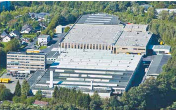
Plant in Betzdorf (D)
